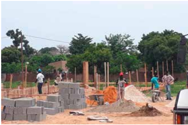
CEM Schule Baback mit 8 Klassenzimmern (4 Blöcke à 2 Klassenzimmer), PC-Raum, Verwaltung und Toiletten (im Bau).
